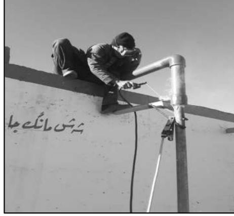
خزان تجميع المياه داخل الناحية، إلتقطت بتاريخ (٢٠٢١/١٢/١٢)
